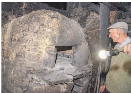
Horno casero de As Portas, hecho en parte de antiguos ladrillos
