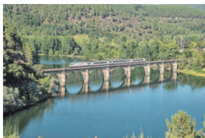
Viaducto ferroviario de Rairos visto desde la ruta
